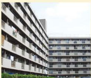
現場全景(千葉県某物件)
