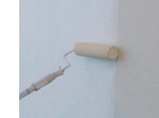
仕上げ材施工
