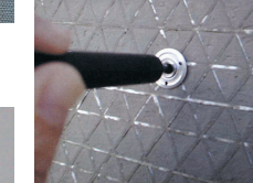
アンカーピン打込み
