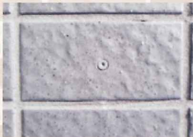
⑧ GNSアンカー打込み完了
