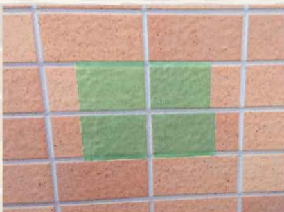
① パイオランテープをタイルに貼り付ける
