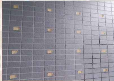
② アンカー位置マーキング
