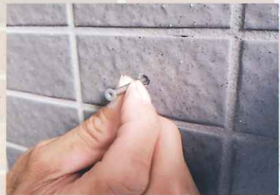
⑥ GNSアンカー挿入
