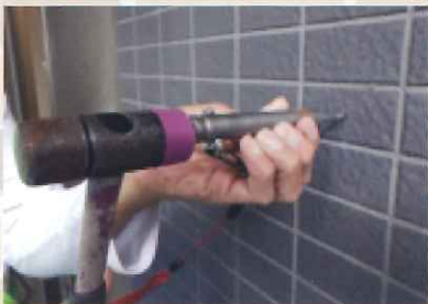
⑦ GNSアンカー打込み
