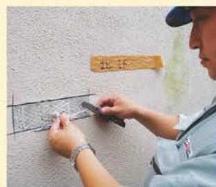
GNSネット抜き取り
